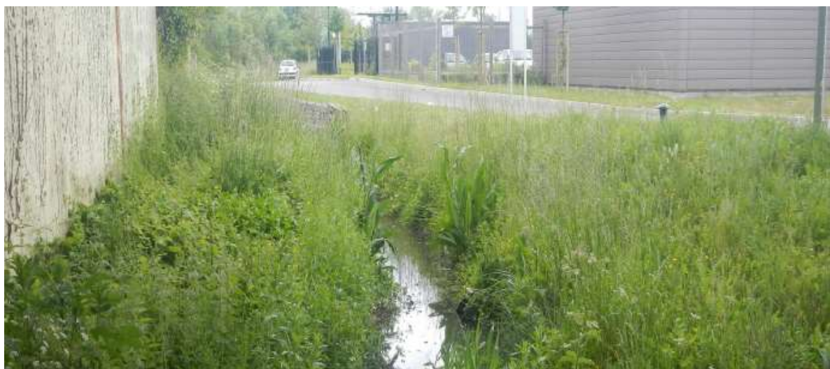
Tronçon coté dépôt Bus
